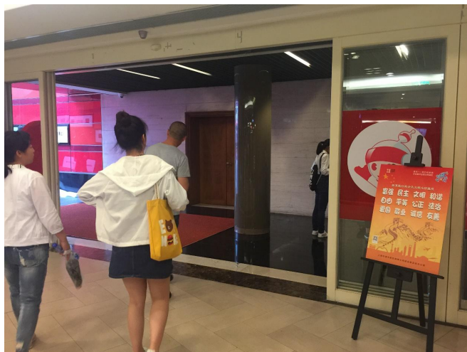
东方明珠塔安装自动移门
